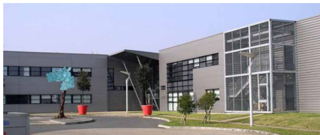
Locaux de la communauté d'agglomération de Tours - Source : P. Lebrun, 2007
