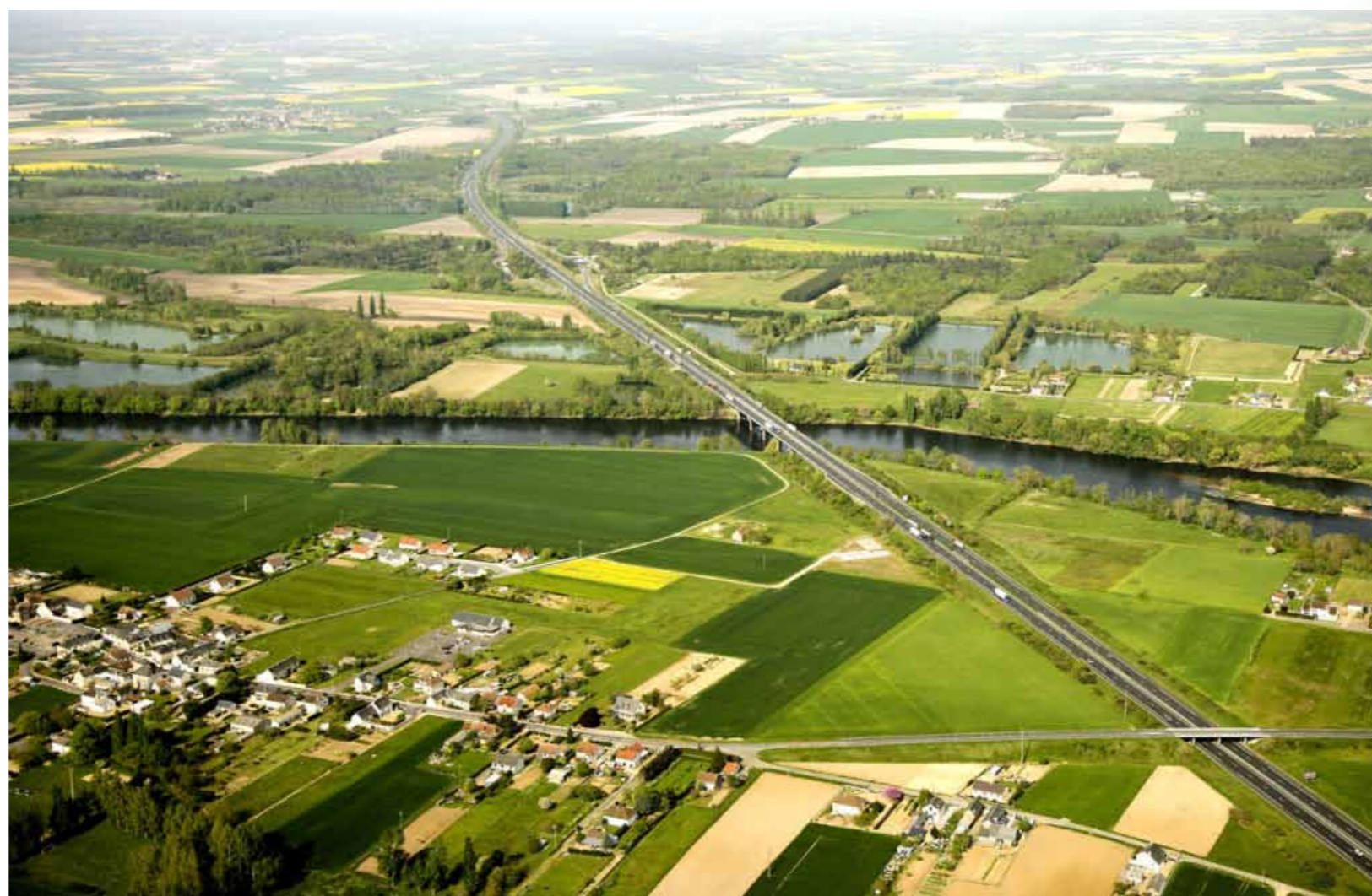
■ Vue aérienne oblique sur la traversée de la Vienne : au nord de la rivière, le hameau des Maisons Rouges sur Nouâtre, et au sud, le village de Ports-sur-Vienne Source : 4 Vents, 2007
