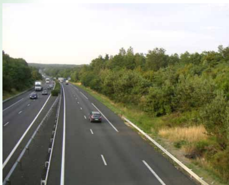
■ L'autoroute A10 abordant la vallée de l'Indre en déblai par rapport aux coteaux Source : Atelier BKM, 2004
