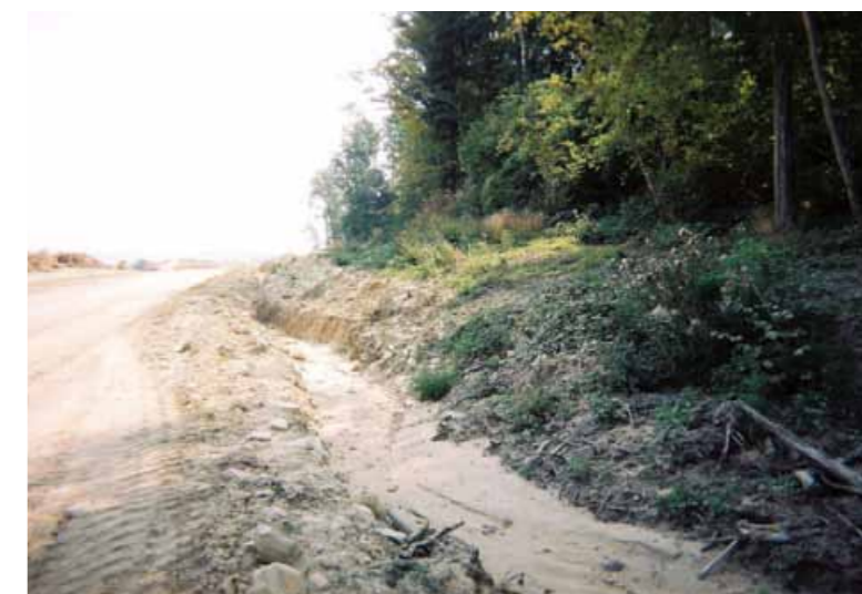
■ Passage de l'emprise du chantier de la LGV Est européenne au droit d'un massif boisé (Source : Equipement et Environnement, 2003)
