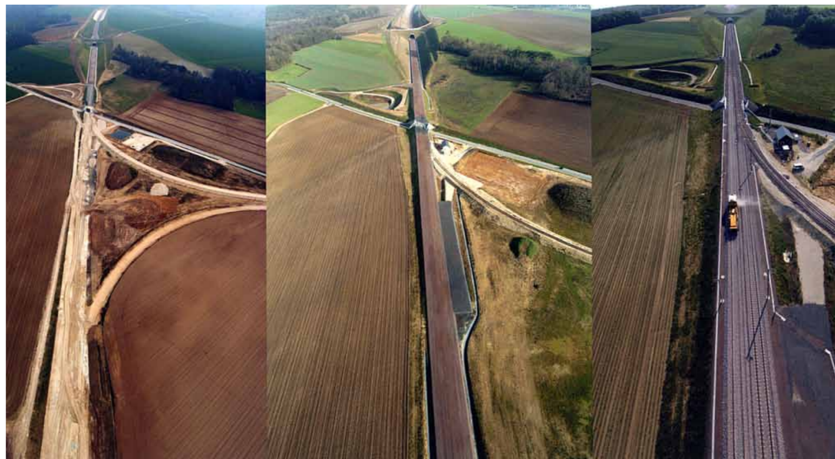
■ Construction de la LGV EST Européenne (avril 2004 - janvier 2005 - juin 2006) (Source : Troll, 2006)
