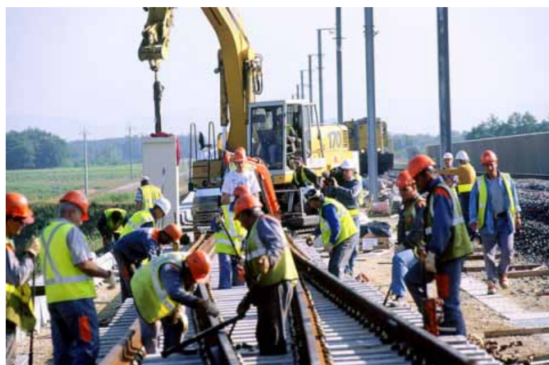
Chantier mobile de pose des voies (source : RFF)
