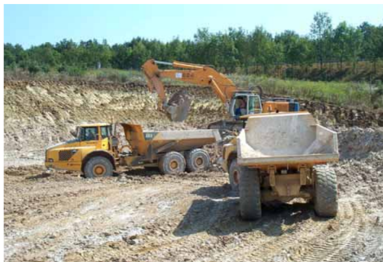
Engins de terrassement (LGV Est Européenne) (Source : Equipement et Environnement, 2003)
