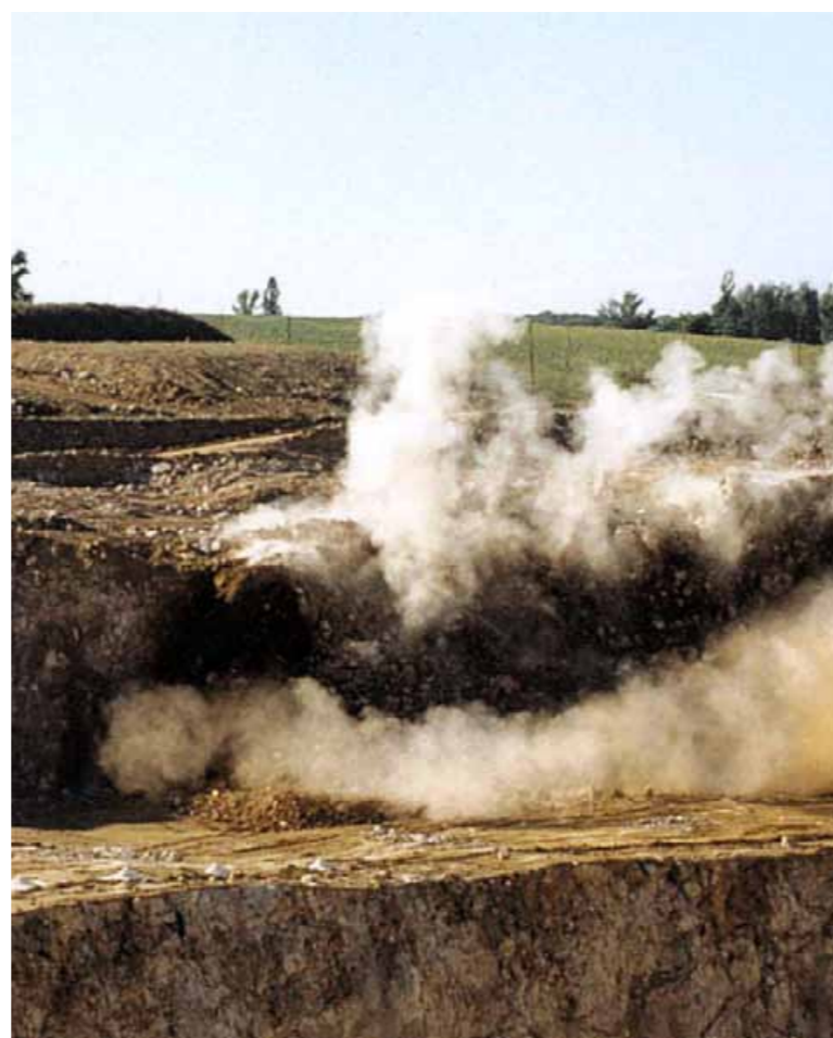
Tir de mine pour la réalisation d'un déblai (source : Scetauroute)
