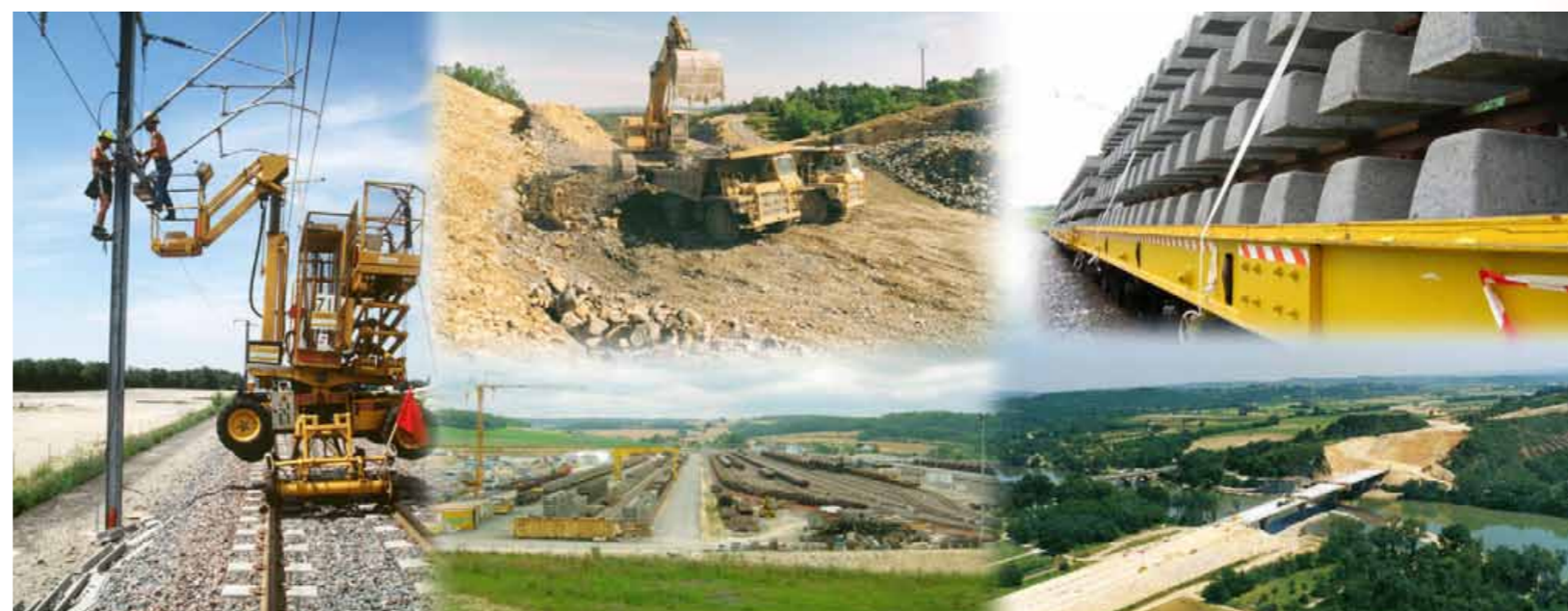
■ Différentes étapes d'un chantier de LGV (Source : RFF)
