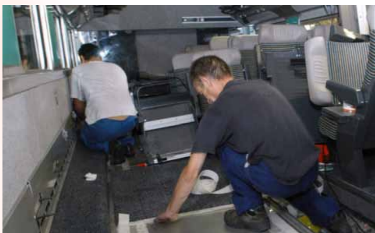
■ Construction de TGV (Source : SNCF)
