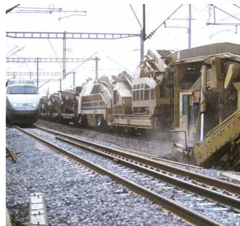
■ Opération de renouvellement sur LGV (Source : RFF)
