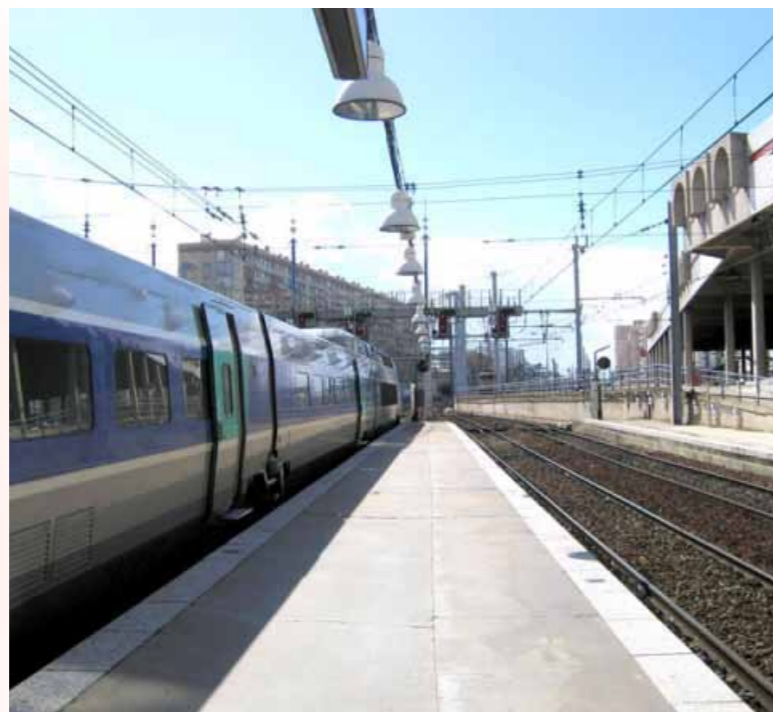
■ Gare Montparnasse (Source : RFF)
