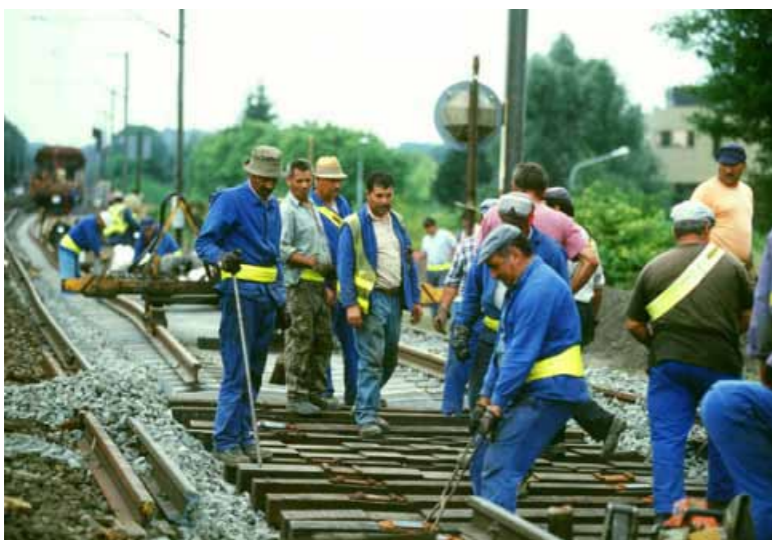
■ Travaux de maintenance (Source : RFF)
