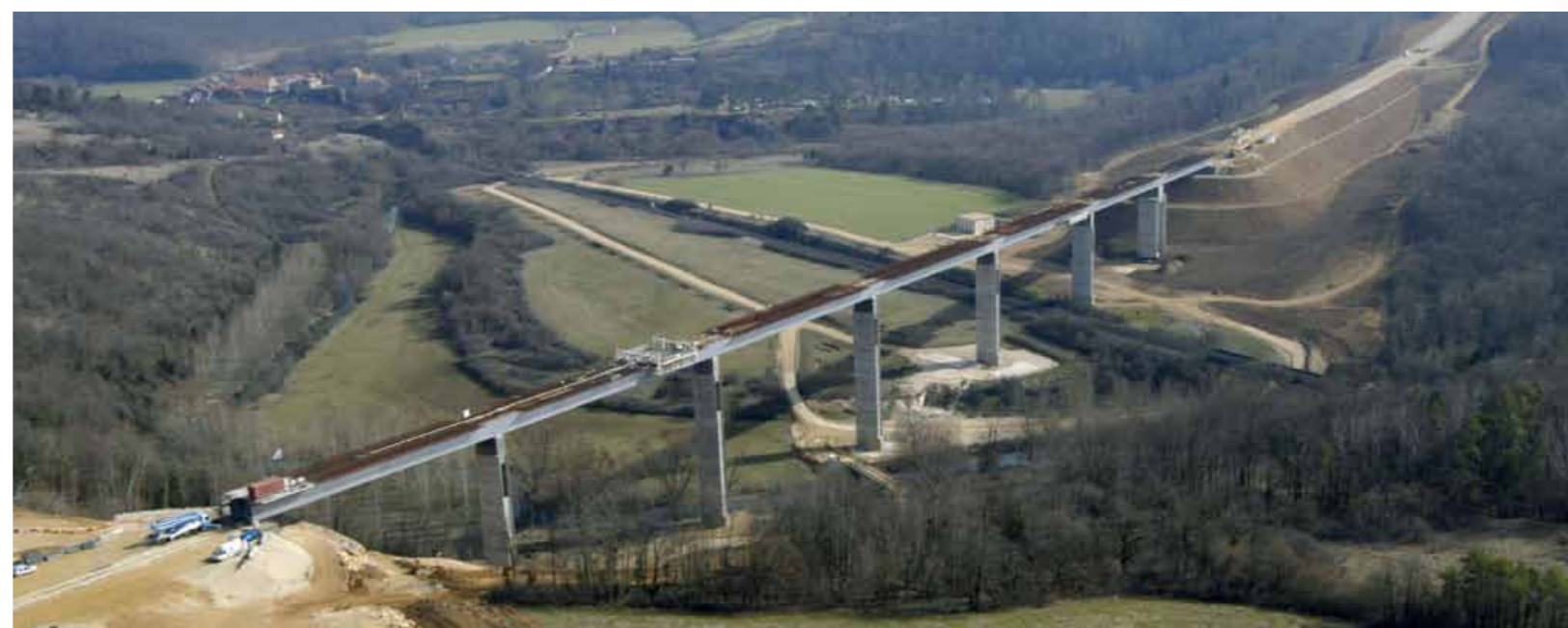
Chantier de LGV (Source : RFF)
