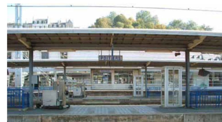
■ La gare de Poitiers (Source : RFF)
