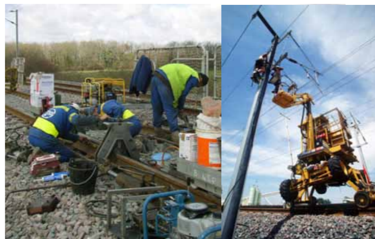
■ Maintenance de LGV (Source : RFF)
