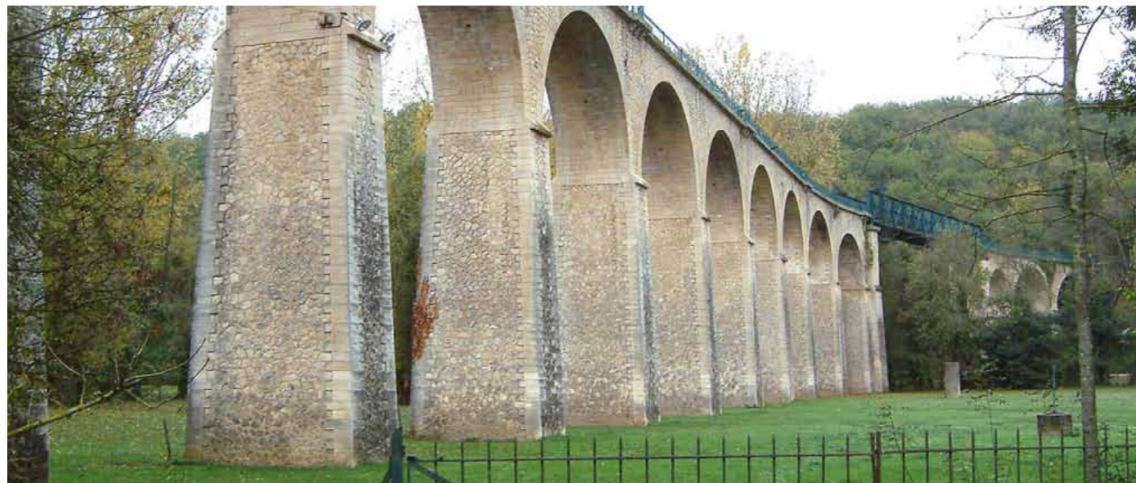
■ Vue sur le viaduc piéton depuis le fond de la vallée de Saint-Benoît (niveau de l'actuelle ligne ferroviaire) (Source : Atelier BKM 2005)
