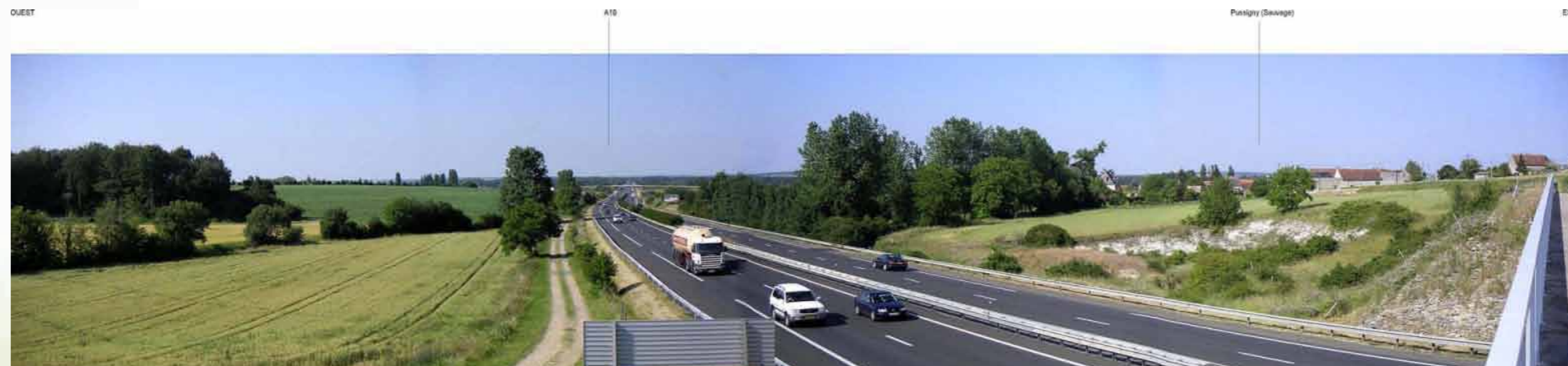
■ Vue depuis le pont sur l'A10 vers le franchissement de la LGV - état initial - Source : Atelier BKM, 2005
