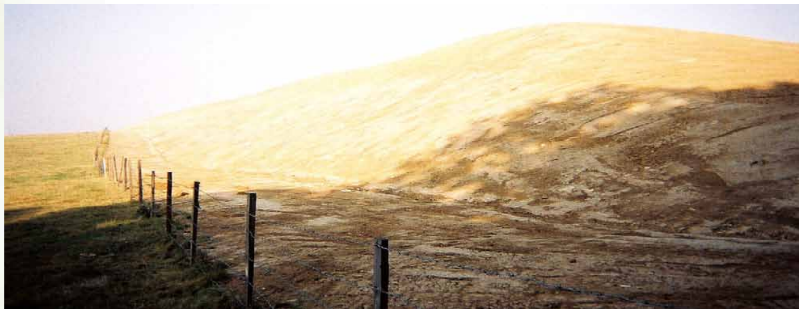
■ Réalisation d'un merlon paysager (LGV Est Européenne) - Source : Equipement et Environnement, 2003
