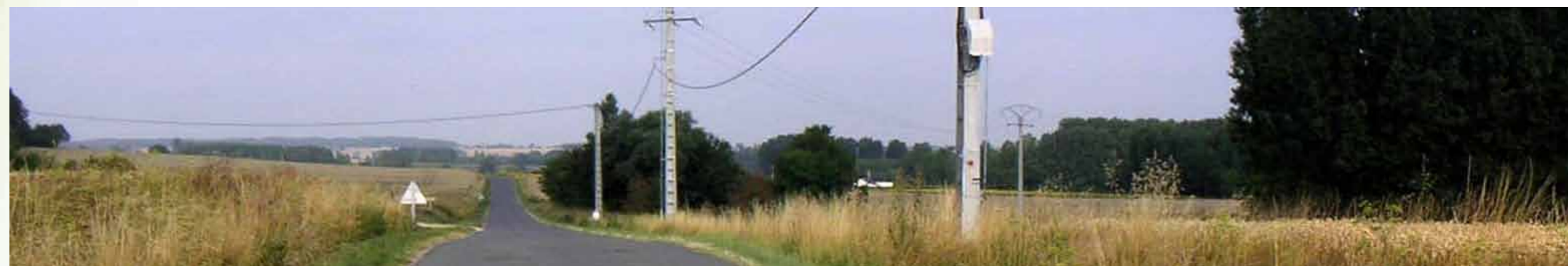
■ Vue sur le passage en pont-rail (zoom) - état initial - Source : Atelier BKM, 2005
