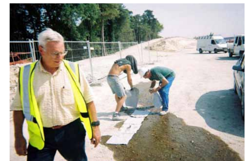
■ Utilisation d'un kit anti-pollution lors d'un déversement accidentel (LGV Est Européenne) - Source : Equipement et Environnement, 2003
