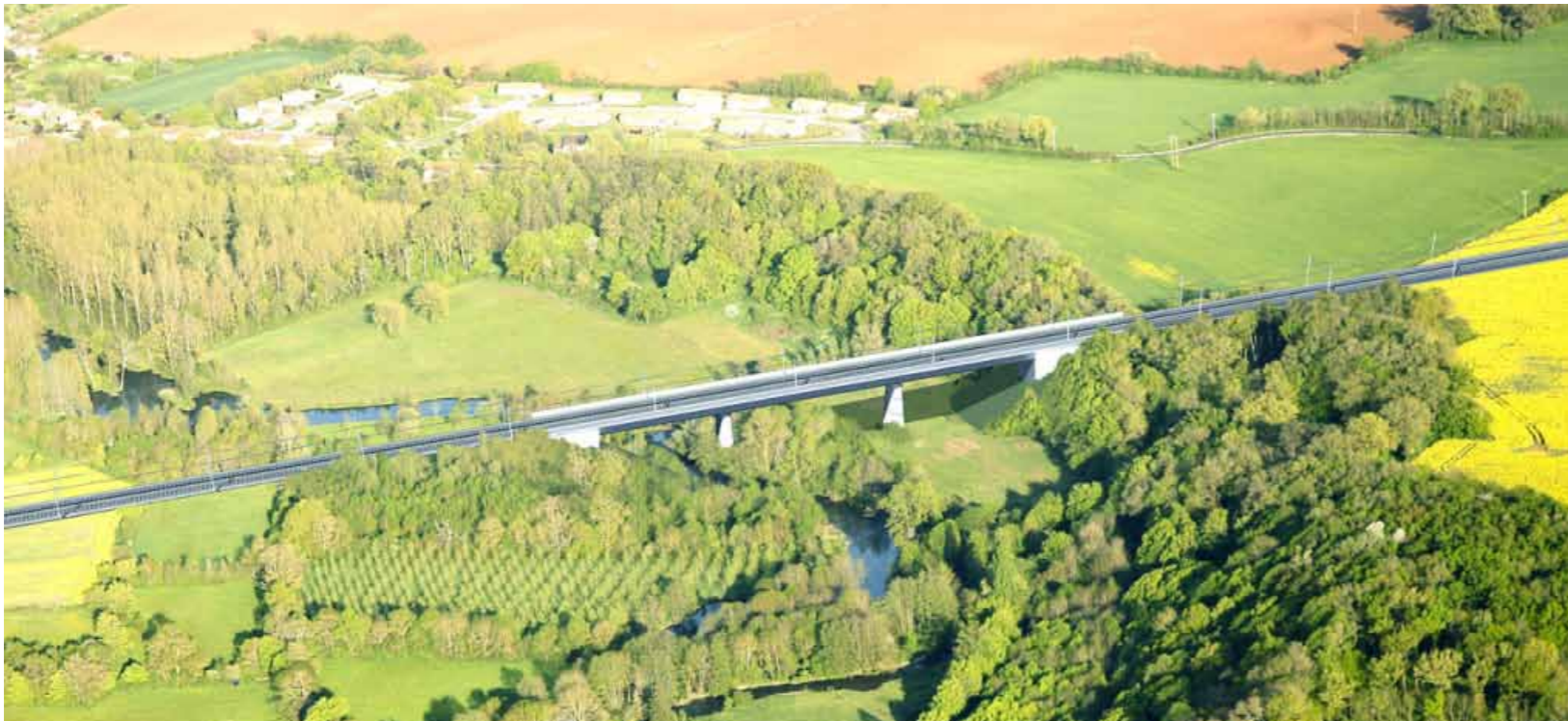
■ Esquisse architecturale du viaduc de la Vonne à Marigny-Chémereau (vue aérienne) - Source : Agence Morris-Renaud, 2007
